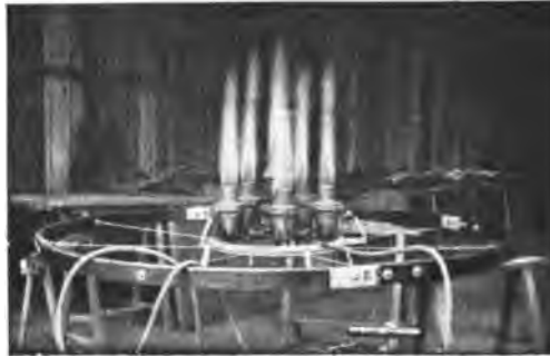
La chaufferie de la Montgolfière militaire Louis Godard montée au centre de son cercle et en fonctionnement. La cheminée enlevée.
